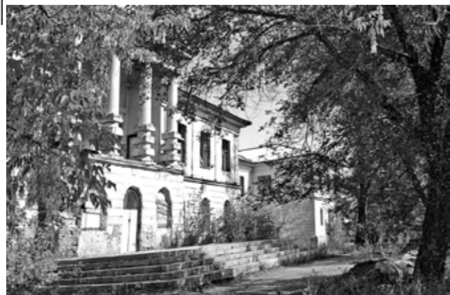
Будинок перед відновленням
